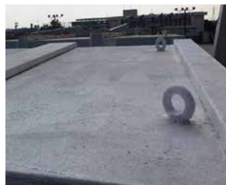
施工から2年後
