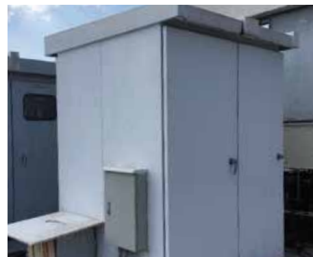
施工から2年後
