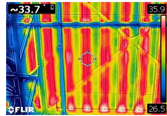
第1工場屋根裏
