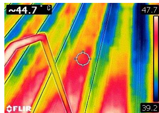
第2工場折板屋根
