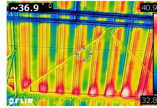
第1工場屋根裏
