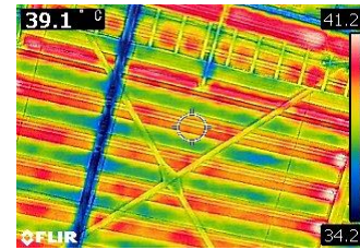
第1工場屋根裏
