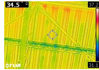
第2工場屋根裏
