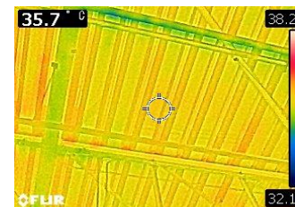
第2工場屋根裏
