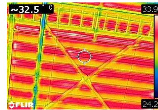
第1工場屋根裏
