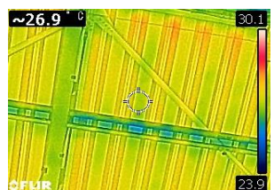
第2工場屋根裏
